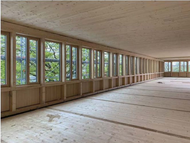
Bild 5 Rathaus Hainburg, Blick auf Rohdecke und Holzfassade (Quelle: Studio Bornheim) Hainburg town hall, view of the slab and timber façade
