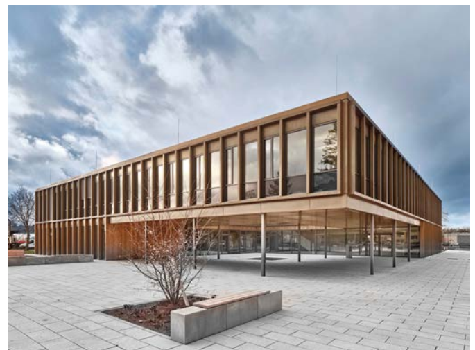
Bild 1 Rathaus Hainburg (Quelle: Norbert Miguletz) Town hall Hainburg
