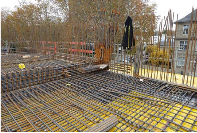
Bild 12 Hochhängung der Lasten Decke über dem Vortragssaal an der Rheinstraße in die Wandscheiben im OG (Quelle: B + G) Suspension of the load ceiling above the lecture theatre on Rheinstraße through the wall panels on the upper floor
