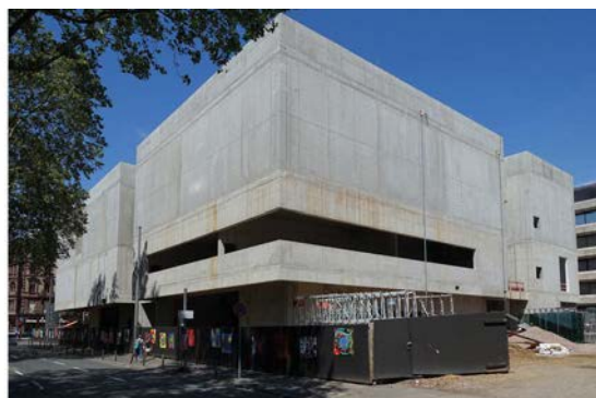
Bild 11 Fensterband in monolithischer Außenwand im Modell (links), ausgeführt (rechts) (Quelle: B + G) Window strip in monolithic exterior wall in the model (left), and completed (right)
