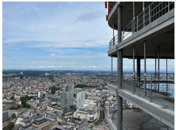
Bild 13 T1: Blick auf die Deckenkonstruktion in Halbfertigteilbauweise (Quelle: ATW FOUR)
